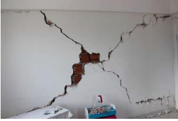
Şekil 42. 24 Ocak 2020 Sivrice (Elazığ) depreminde oluşan zayıf dolgu duvar hasarları [19]
