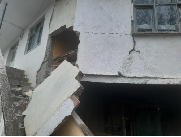
Şekil 43. 23 Kasım 2022 Gölyaka (Düzce) depreminde oluşan zayıf dolgu duvar hasarları
