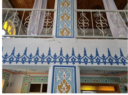
(a) Betonarme camii hasarları
