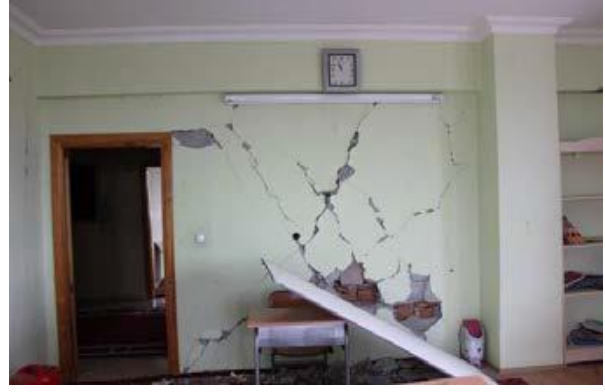
Şekil 42. 24 Ocak 2020 Sivrice (Elazığ) depreminde oluşan zayıf dolgu duvar hasarları [19]
