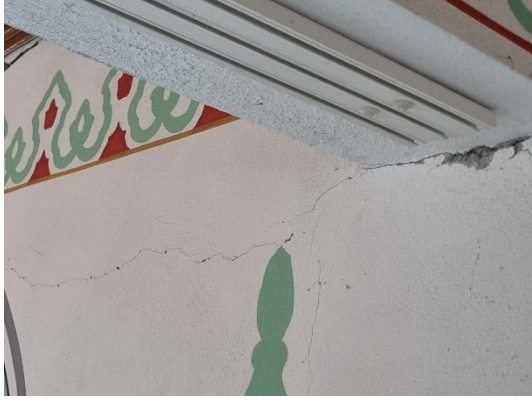
(a) Betonarme camii hasarları
