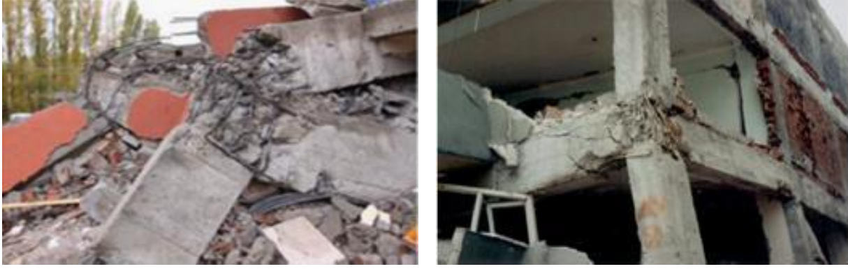
Şekil 38. (a) 9 Kasım 2011 Van [20] ve (b) 17 Ağustos 1999 [21] Kocaeli depreminde tespit kolon-kiriş birleşim bölgesi hasarları
