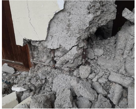
Şekil 51. 23 Kasım 2022 Gölyaka (Düzce) depreminde tespit edilen nervürsüz donatı ve korozyon hasarları
