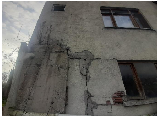
Şekil 37. 23 Kasım 2022 Gölyaka (Düzce) depreminde tespit edilen kolon-kiriş birleşim bölgesi hasarları
