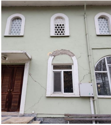
(a) Betonarme camii hasarları
