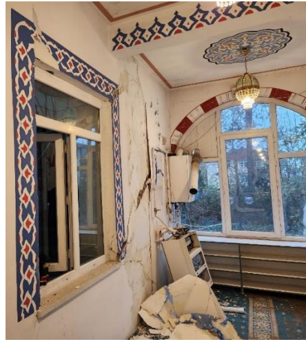
(a) Betonarme camii hasarları
