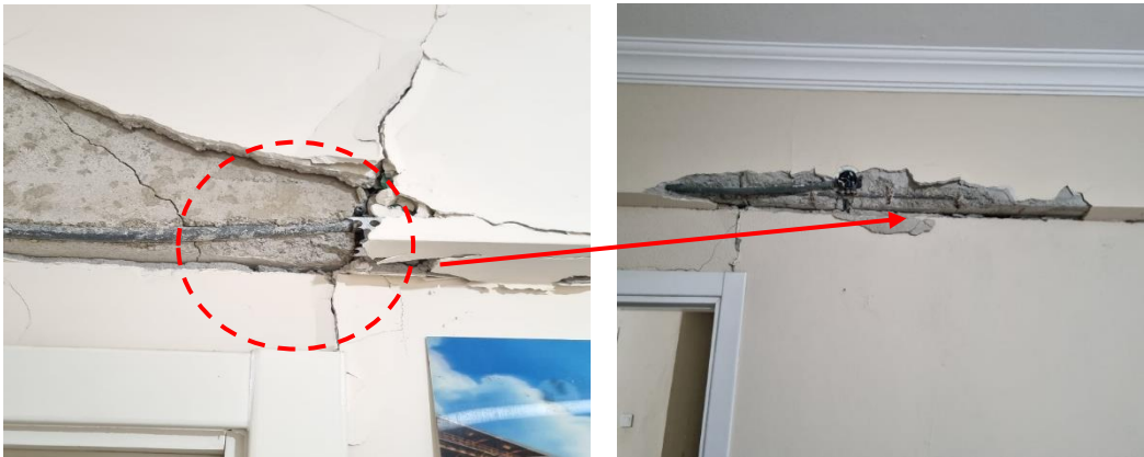
Şekil 52. 24 Ocak 2020 Sivrice (Elazığ) depreminde tespit edilen işçilik hataları [16]
