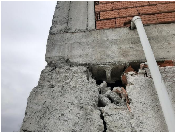
Şekil 37. 23 Kasım 2022 Gölyaka (Düzce) depreminde tespit edilen kolon-kiriş birleşim bölgesi hasarları
