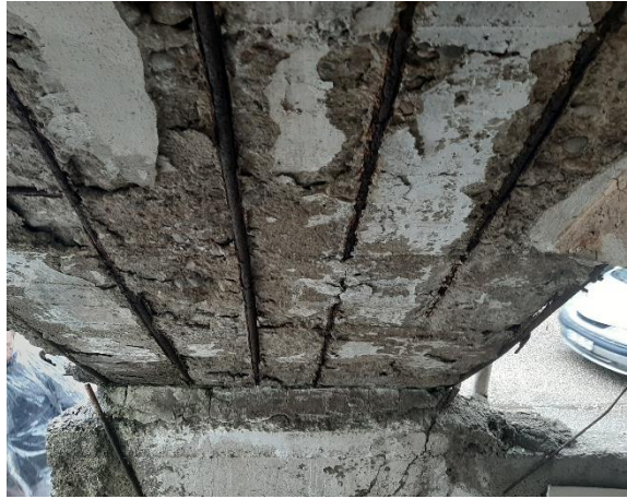
Şekil 51. 23 Kasım 2022 Gölyaka (Düzce) depreminde tespit edilen nervürsüz donatı ve korozyon hasarları
